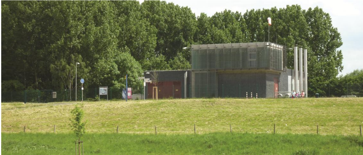
Pumpanlage Werthweg; Aufnahme vom 13. Mai 2011
