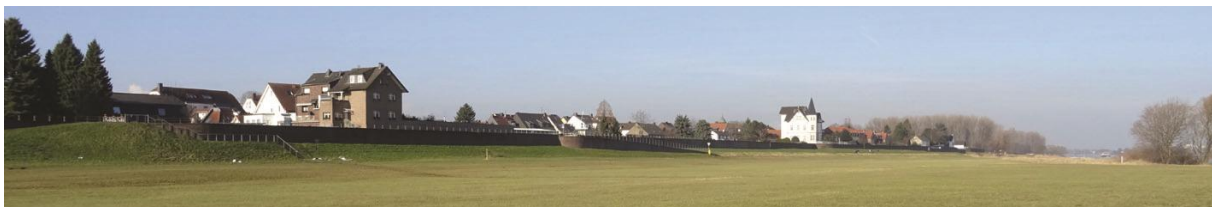
Hochwasserschutzwand Langel; Aufnahme vom 18. Februar 2018
