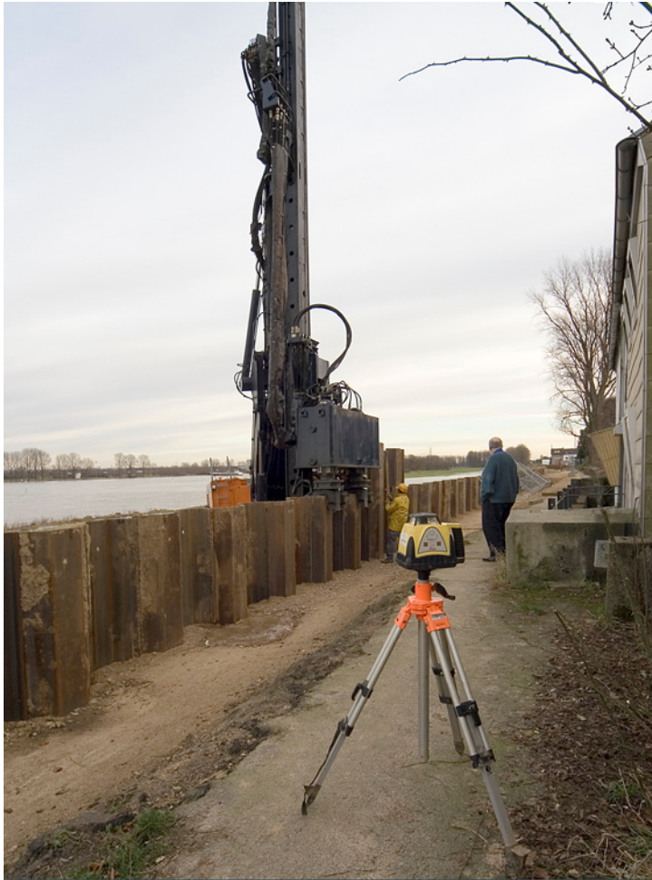
Einbau von Spundwänden; 27. Januar 2007
