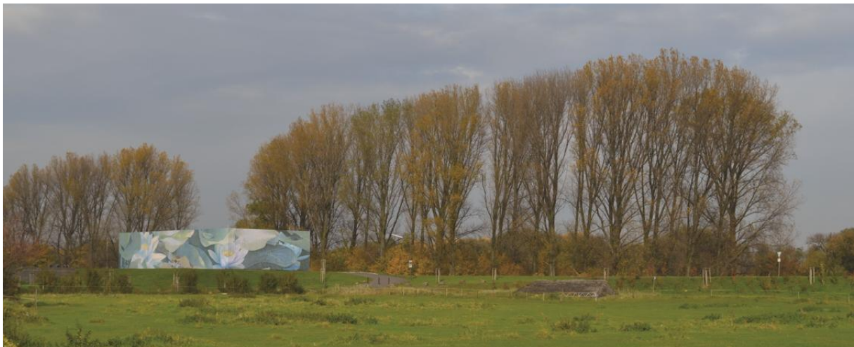
Pumpanlage Kuhlenweg; Aufnahme vom 5. November 2015
