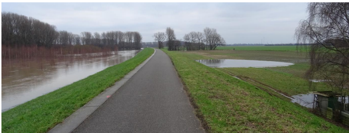
Worringer-Langeler Deich mit Grundwasseraustritt (Grundhochwasser) hinter dem Deich
