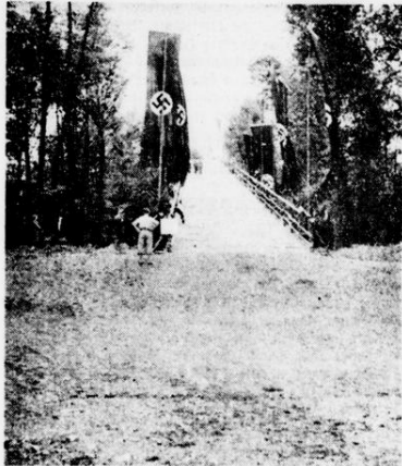
Gesamtansicht der Sprungschanze
