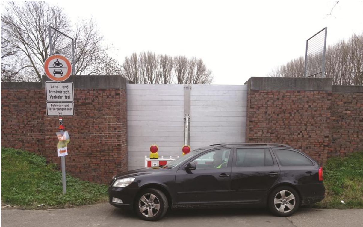
Hochwasserschutztor Rheinkassel; Aufnahme vom 8. Januar 2018 bei 8,77m Kölner Pegel
