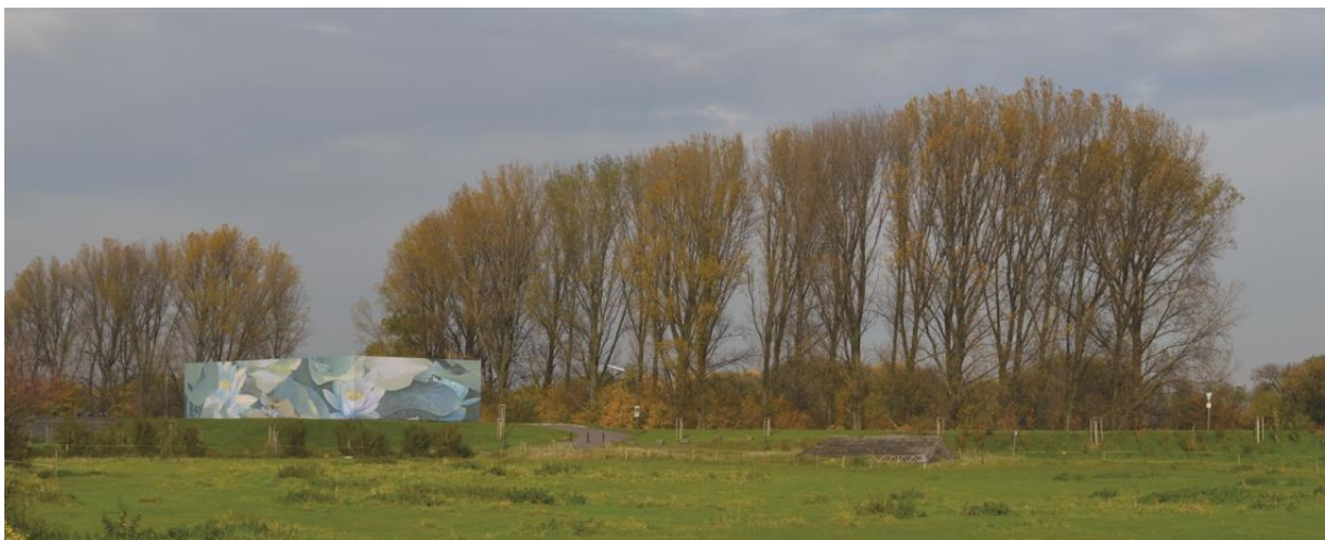
Pumpanlage Kuhlenweg; Aufnahme vom 5. November 2015
