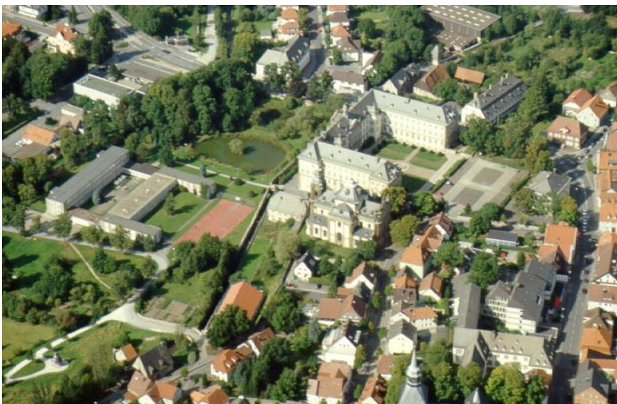
Luftbild des Jesuitenkollegs Büren, Kreis Paderborn Walter Neuling, LWL-Amt für Landschafts- und Baukultur in Westfalen, 1999
