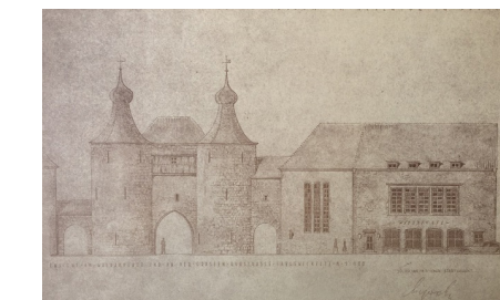
Baufaufnahme Hexenturm März 1949
