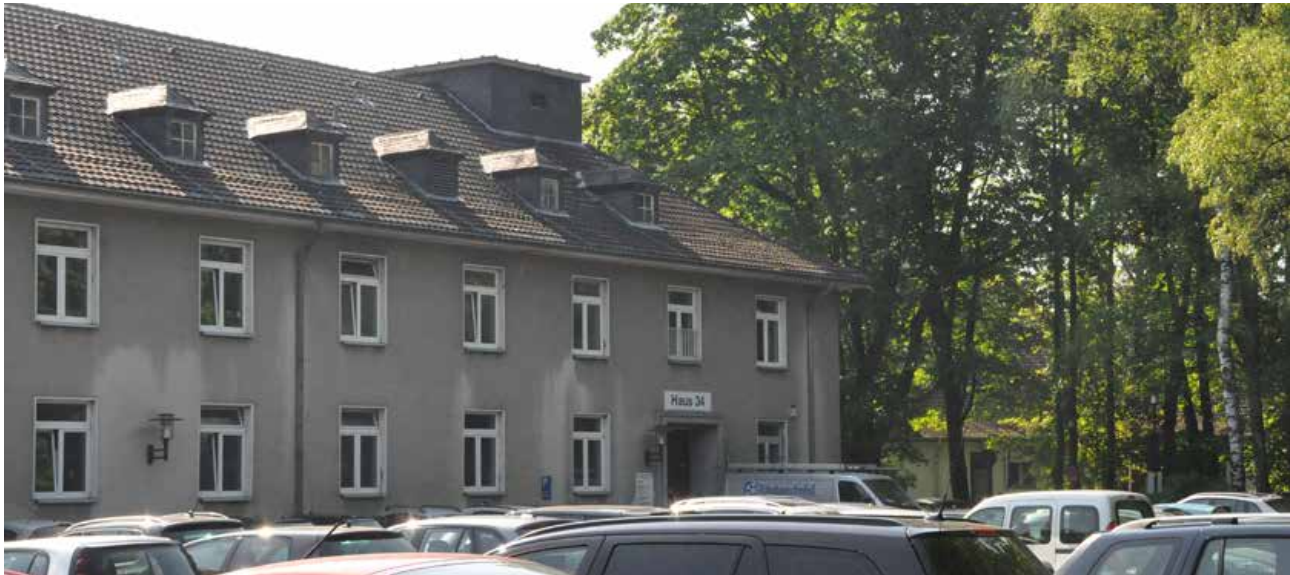
Abb. 20 | Ehemalige Gebäude des militärischen Flugplatzes Ostheim (Foto: Nicole Schmitz, 2017)
