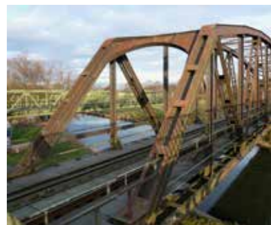
Brücke Wandhofen in Schwerte // Foto: LWL
