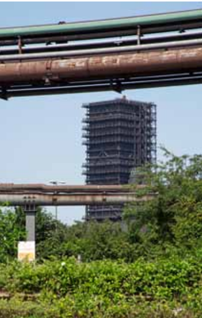
Thyssen-Stahlwerk in Duisburg-Bruckhausen
