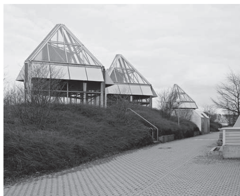
12. Universitätsklinikum. Ansaugöffnungen der Klimaanlage. Foto: Jürgen Gregori, LVR-ADR, 2000.
