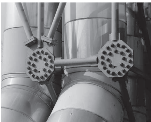
11. Universitätsklinikum. Konstruktionsdetail an Lüftungsrohren. Foto: Jürgen Gregori, LVR-ADR, 2000.
