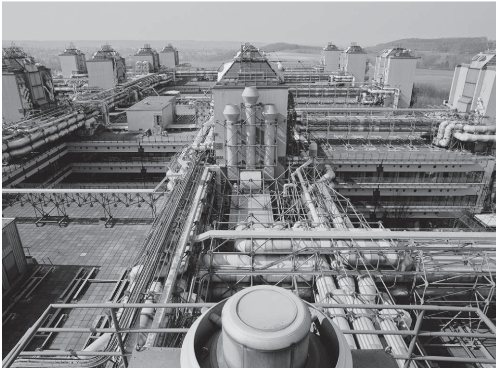
8. Universitätsklinikum. Dach in Richtung Westen mit Öffnungen von Lichthöfen. Foto: Jürgen Gregori, LVR-ADR, 2000.
