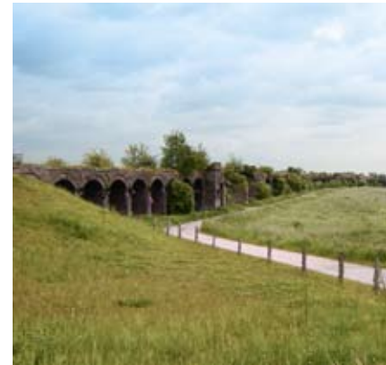
Brücke einer aufgelassenen Eisenbahntrasse bei Wesel, Niederrhein // Foto: LVR/Archiv
