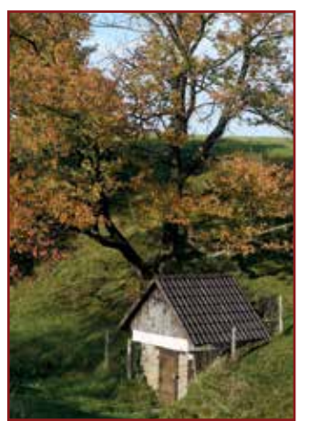
21 Brunnenhäuschen in Ballsiefen
