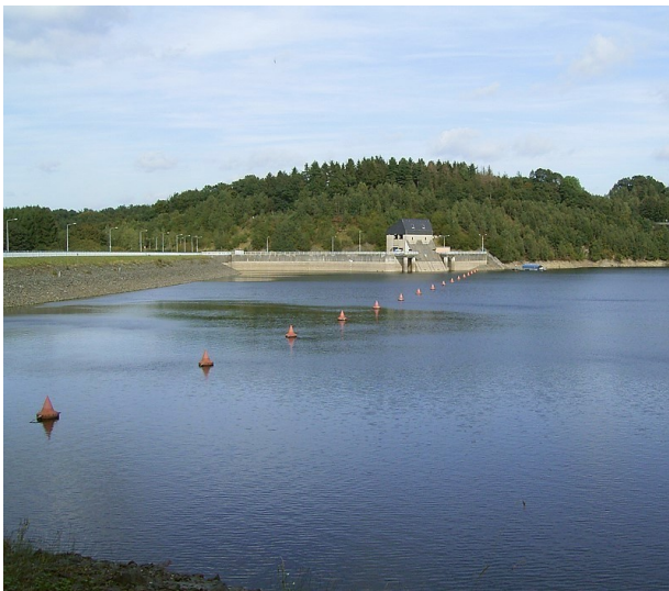
Staudamm der Wuppertalsperre in Radevormwald-Krebsöge (2007) Fotograf/Urheber: Frank Vincentz
