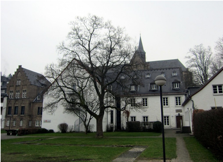
Zisterzienserabtei Altenberg, links das ehemalige Pfarrhaus (2012) Fotograf/Urheber: Knöchel, Franz-Josef
