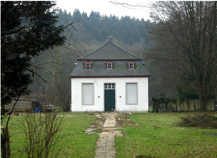
Zisterzienserabtei Altenberg, Gartenhaus im Süden (2012) Fotograf/Urheber: Knöchel, Franz-Josef
