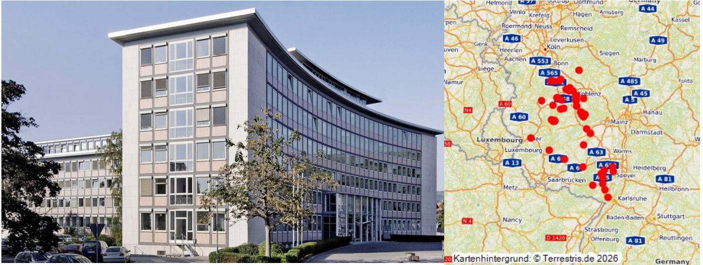
Verwaltungsgebäude Friedrich-Ebert-Straße 14 Neustadt Fotograf/Urheber: SGD Süd
