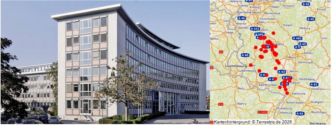
Verwaltungsgebäude Friedrich-Ebert-Straße 14 Neustadt Fotograf/Urheber: SGD Süd
