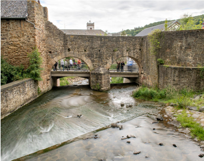
Bad Münstereifel. Der Durchlass der Erft in der Stadtmauer mit den Bögen der Oberen Schosspforte, dahinter die Werkbrücke. Fotograf/Urheber: Marcel Zanjani / LVR-Amt für Bodendenkmalpflege im Rheinland
