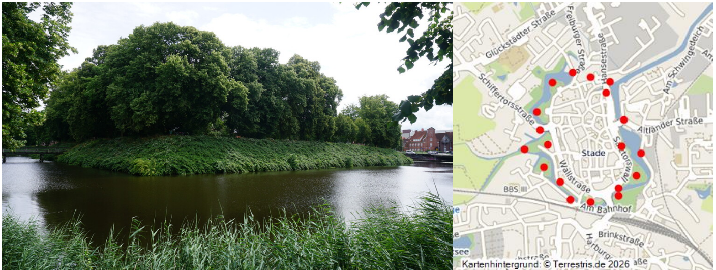
Stade, Georg-Bastion / Schiffertorsbastion. Bastionsspitze (2013) Fotograf/Urheber: Claus Weber
