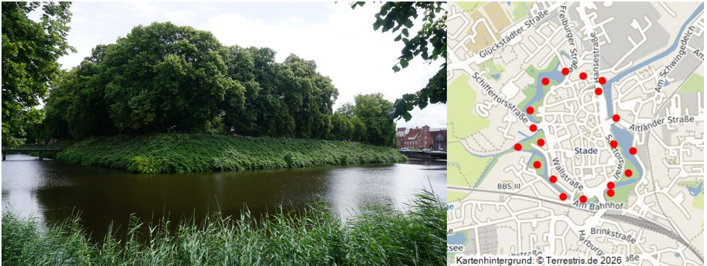
Stade, Georg-Bastion / Schiffertorsbastion. Bastionsspitze (2013) Fotograf/Urheber: Claus Weber
