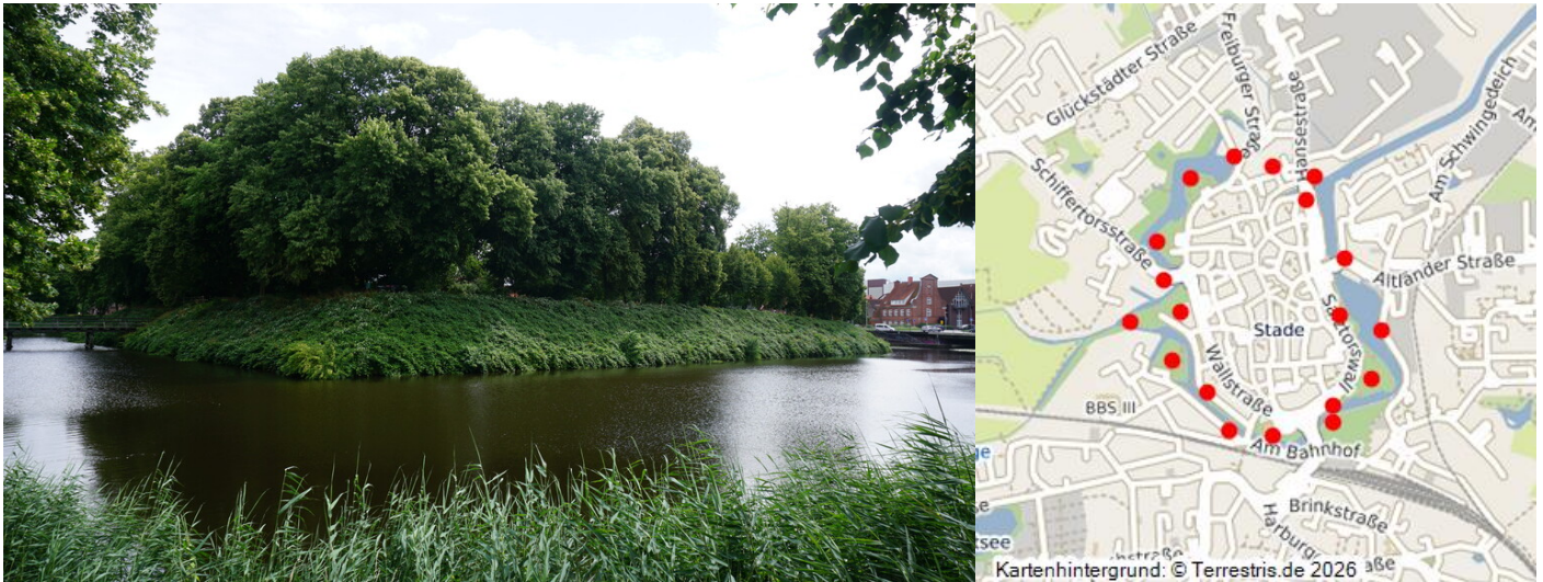
Stade, Georg-Bastion / Schiffertorsbastion. Bastionsspitze (2013) Fotograf/Urheber: Claus Weber
