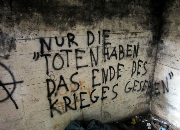
Stahlbeton-Bunker an der Artilleriestellung Sicherheitsstand 11 in der Wahner Heide (2011). Das Graffiti im Inneren lautet "Nur die Toten haben das Ende des Krieges gesehen". Fotograf/Urheber: Franz-Josef Knöchel
