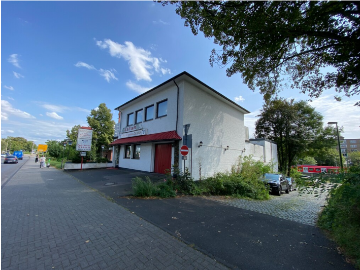
Ehemaliges Verwaltungsgebäude der Steinzeugfabrik Hensmann (2024) Fotograf/Urheber: Nicole Schmitz
