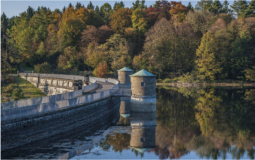
Staumauer der Neyetalstalsperre bei Wipperföhrt (2019) Fotograf/Urheber: Holger Klaes
