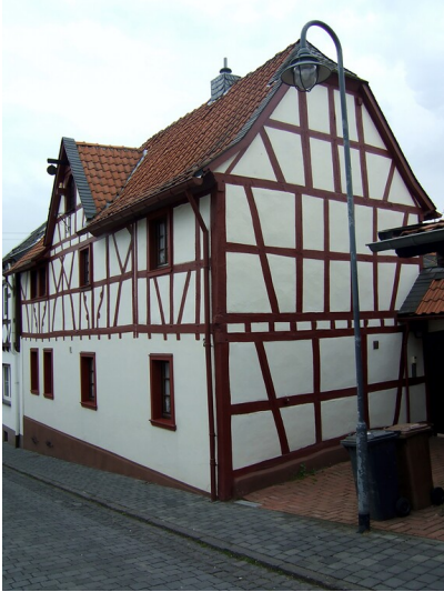
Fachwerkhaus Kreuzstraße 2 in Sinzig-Löhndorf (2012) Fotograf/Urheber: Hans D. Jüchtern
