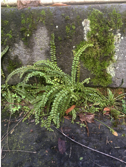
Innenseite der nördlichen Außenmauer der Stadt Zons (2018) Fotograf/Urheber: Martin Sorg
