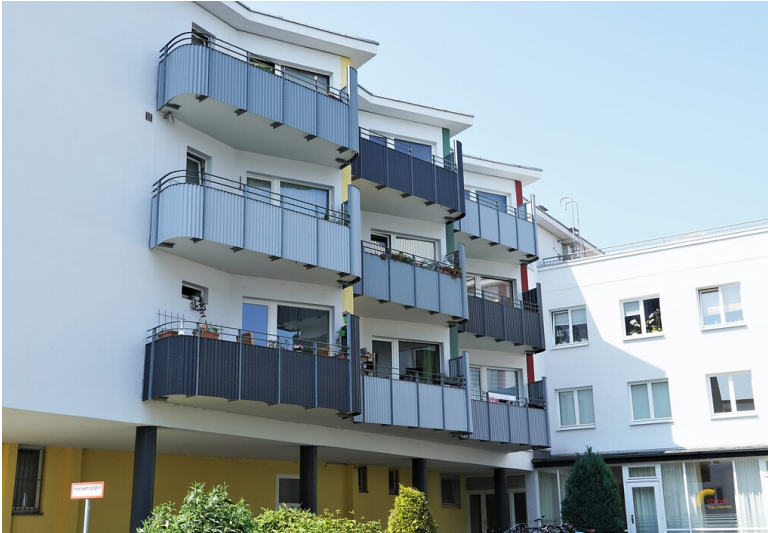
Appartmentkomplex Uhlandstraße 23 in Lindenthal (2022) Fotograf/Urheber: Sandro Golia
