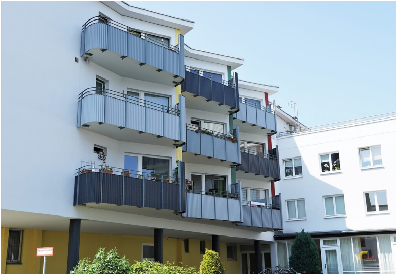
Appartementkomplex Uhlandstraße 23 in Lindenthal (2022) Fotograf/Urheber: Sandro Golia
