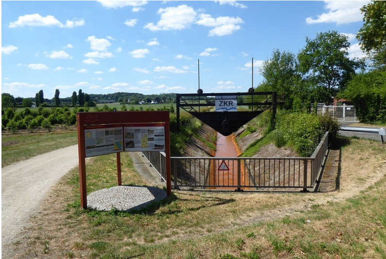
Ankerpunkt Aachener Straße des Lehr- und Erlebnispfads Energie & Wasser am Kölner Randkanal (2020) Fotograf/Urheber: Reinhard Zeese
