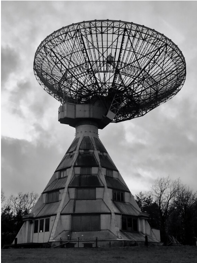
Gesamtansicht des Radioteleskops Astropfeiler Stockert bei Bad Münstereifel-Eschweiler / -Holzheim (2020). Fotograf/Urheber: Robert, Pfeil
