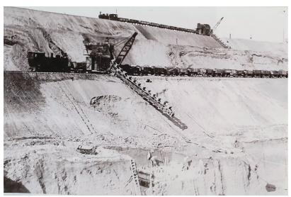
Tonstechen per Hand (Bildvordergrund) und Abbau mithilfe eines Eimerkettenbaggers mit Dampfloks (1920) Fotograf/Lirheber: unbekannt
