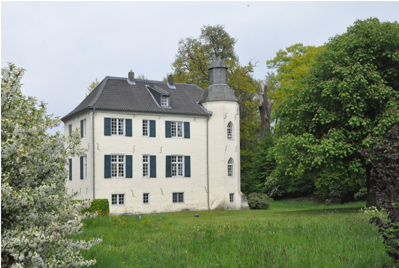
Haus Bey mit Turm (2017) Fotograf/Urheber: Nicole Schmitz
