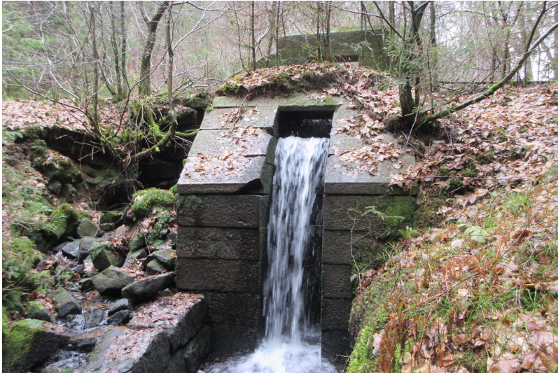
Dammbereich Fotograf/Urheber: Matthias Dreyer
