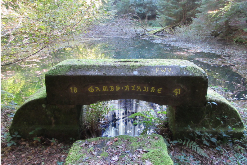
Wasserbauwerk Gams-Klause im Pfälzerwald (2018) Fotograf/Urheber: Matthias C.S. Dreyer
