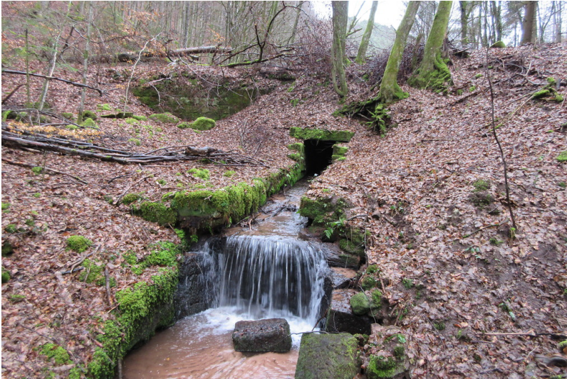
Grundablass am Hansenwoog am Scheidbach Fotograf/Urheber: Matthias Dreyer
