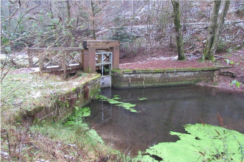
Dammbereich mit dem Absperr- und Auslaufbauwerk
