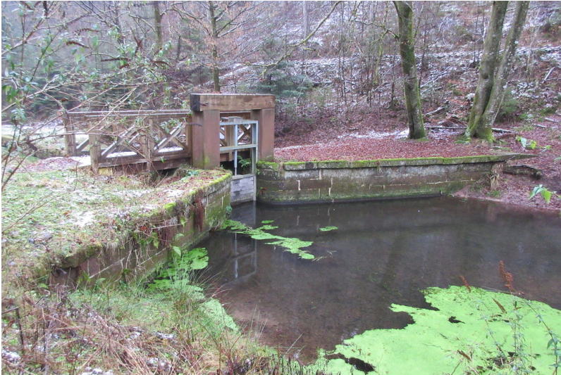
Dammbereich mit dem Absperr- und Auslaufbauwerk Fotograf/Urheber: Matthias Dreyer
