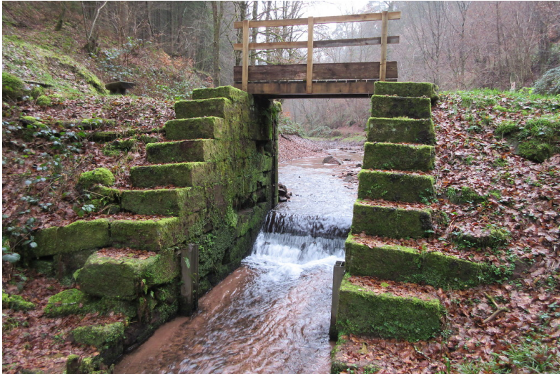
Dammbereich des Pfalzwoogs am Kaltenbach (2018) Fotograf/Urheber: Matthias C.S. Dreyer
