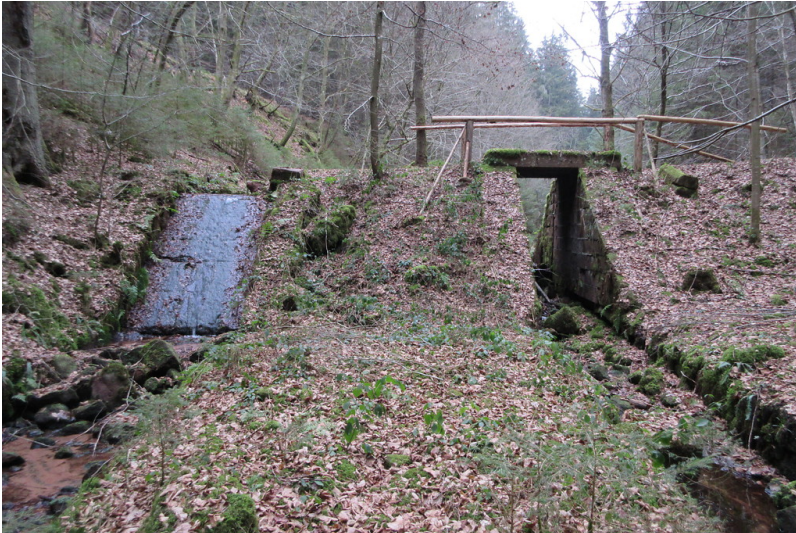
Dammbereich des Goldwooges mit Sohlrampe am Breitenbach (2018) Fotograf/Urheber: Matthias C.S. Dreyer
