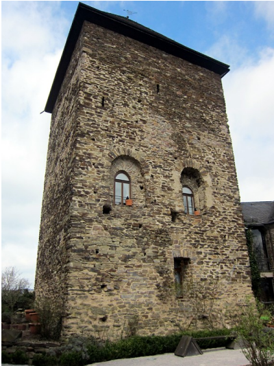
Südöstliche Ansicht des aus dem 12. Jahrhundert stammenden Bergfrieds der Koberner Oberburg (2015) Fotograf/Urheber: Franz-Josef Knöchel
