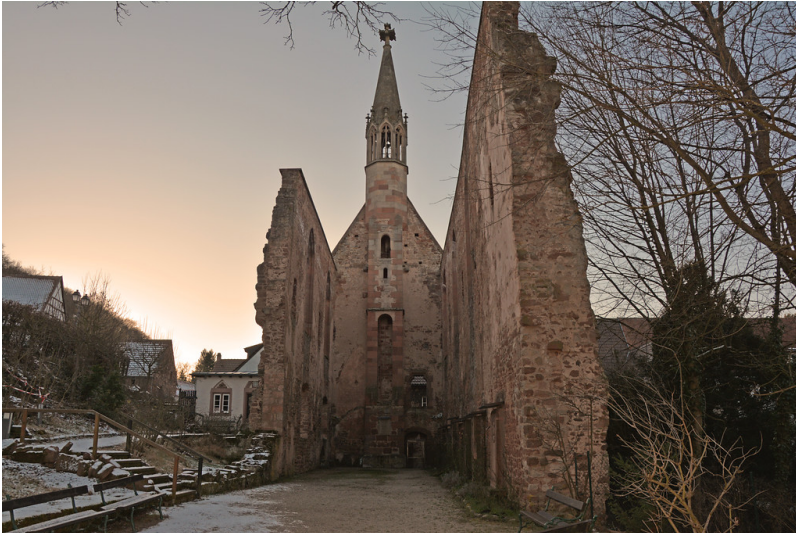
Blick in das ehemalige Kirchenschiff des Klosters Rosenthal in Richtung Turm (2018). Fotograf/Urheber: Sonja Kasprick
