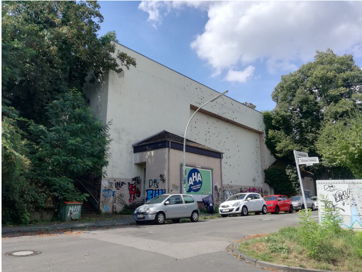
Hochbunker in Bonn-Kessenich (2020) Fotograf/Urheber: Frederic Tempelaars
