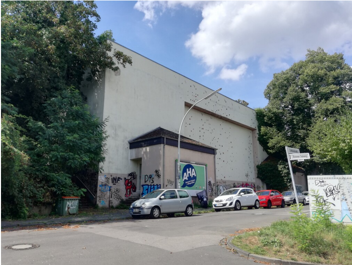
Hochbunker in Bonn-Kessenich (2020) Fotograf/Urheber: Frederic Tempelaars
