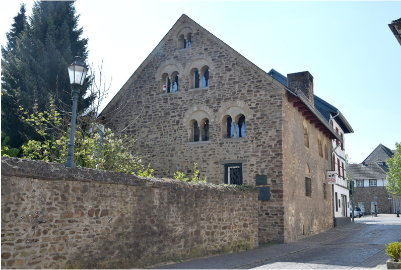
Das Romanische Haus in Bad Münstereifel, Ansicht von der Straße Langenhecke (2017) Fotograf/Urheber: Karin White-Rahneberg
