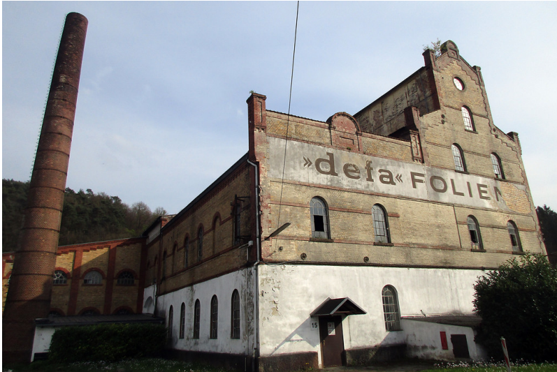
Hauptfassade des zentralen Gebäudes und Schornstein der Aggerhütte bei Lohmar-Honrath: früher Kupfererzhütte und Extraktionswerk Aggermühle (2017). Fotograf/Urheber: Franz-Josef Knöchel
