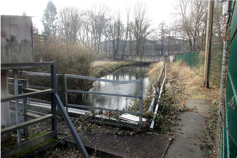
Stau- und Wehranlagen am Abzweig des Troisdorfer Mühlengrabens von der Agger, im Hintergrund Teile des früheren Hüttenwerks Friedrich-Wilhelms-Hütte, heutige Mannstaedt-Corus GmbH (2017). Fotograf/Urheber: Franz-Josef Knöchel
