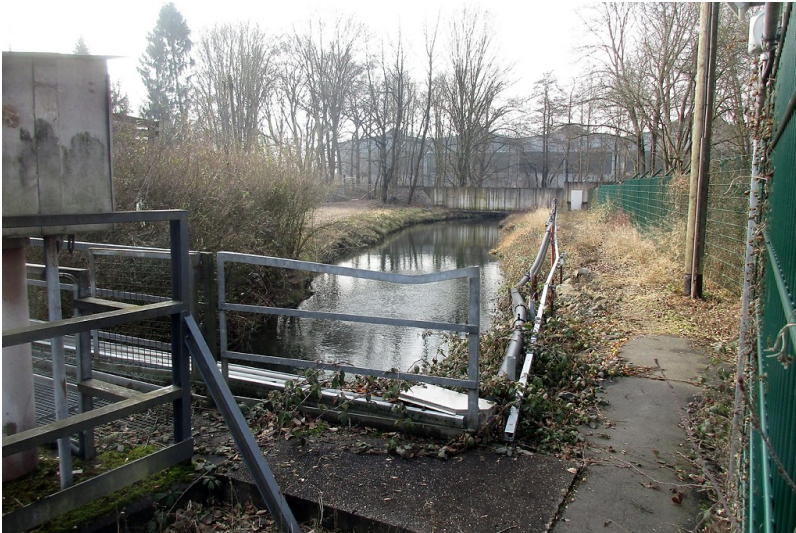
Stau- und Wehranlagen am Abzweig des Troisdorfer Mühlengraben von der Agger, im Hintergrund Teile des früheren Hüttenwerks Friedrich-Wilhelms-Hütte, heutige Mannstaedt-Corus GmbH (2017). Fotograf/Urheber: Franz-Josef Knöchel
