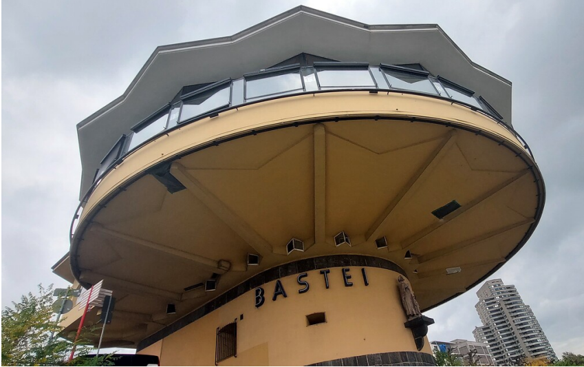
Blick vom Kölner Rheinufer auf die Restaurantplattform des Panorama-Restaurants "Bastei" in Neustadt-Nord (2021). Fotograf/Urheber: Franz-Josef Knöchel
