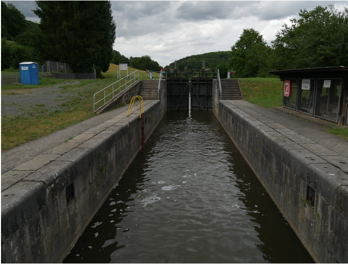
Kammer der Schleuse Fürtfurt bei Villmar (2017) Fotograf/Urheber: Jörn Schultheiß
