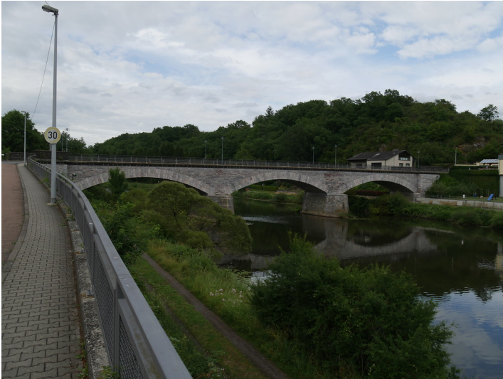
Südansicht der Marmorbrücke in Villmar (2017) Fotograf/Urheber: Jörn Schultheiß
