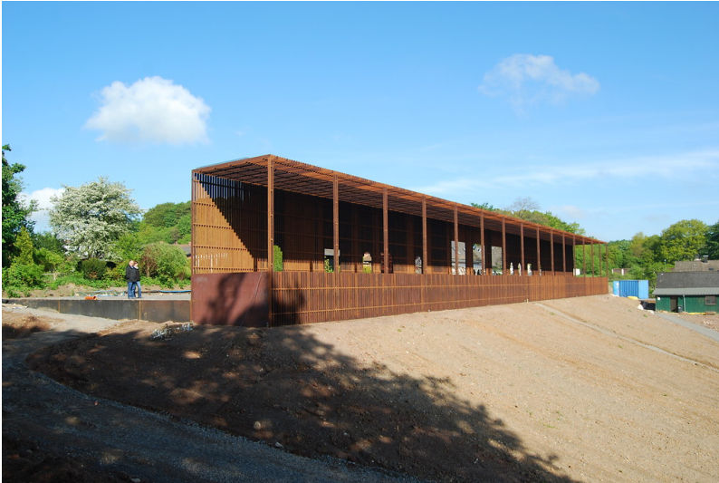
Rekonstruktion der Portikus der Römervilla in Blankenheim (2014) Fotograf/Urheber: Ulrike Müssemeier
